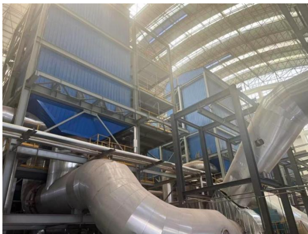
图4.1-5 SCR反应塔
