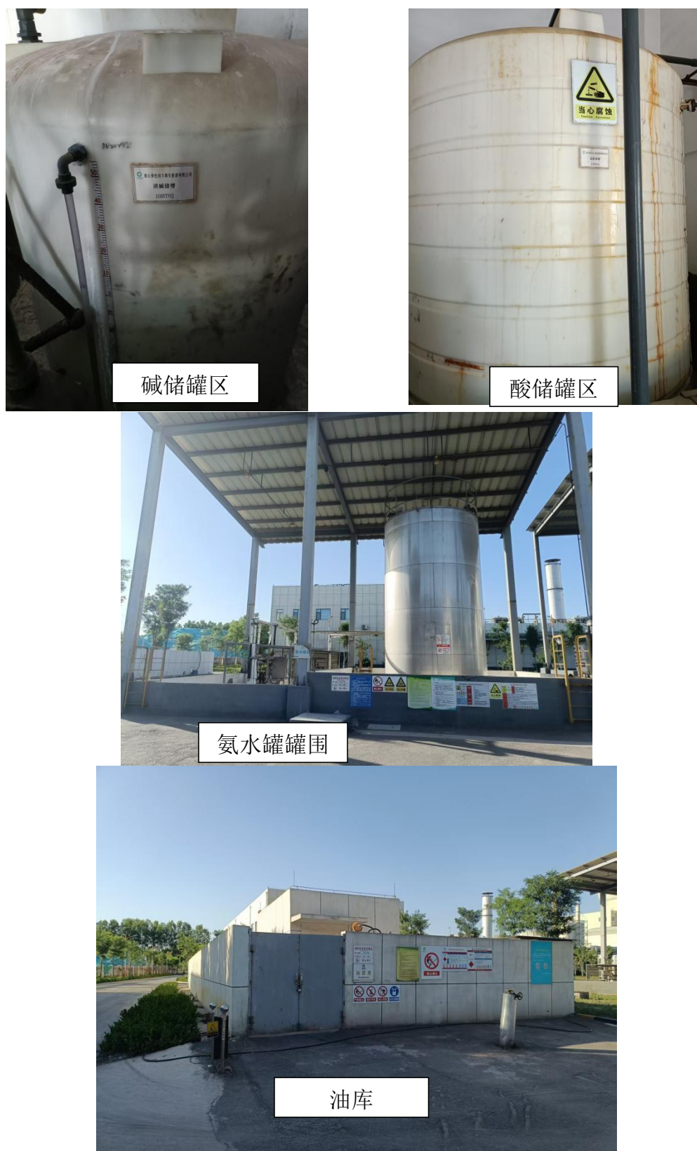
图4.2-4 氨水罐区围堰、油库等现场照片
