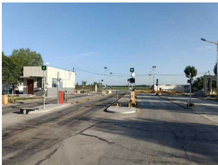
图3.5-2 地磅现场照片
