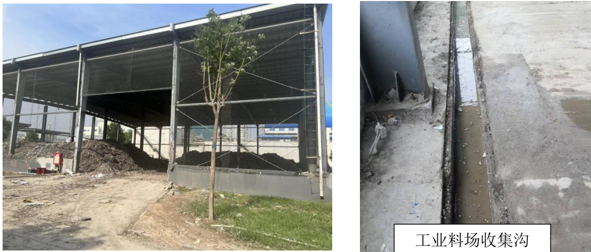
图3.5-6 工业料场现场照片
