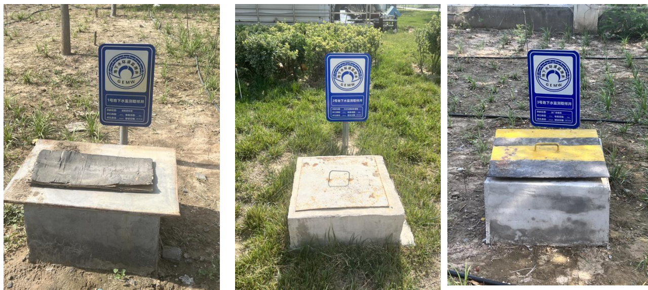
图4.2-3 地下水监测井
