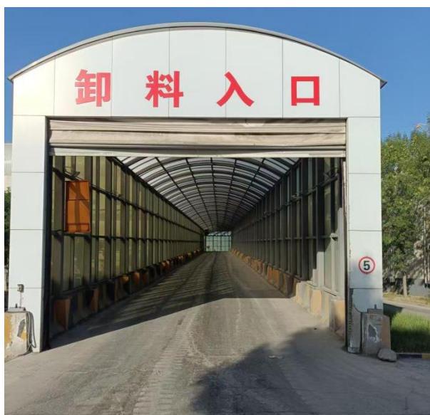
图3.5-3 进料坡道感应门现场照片
