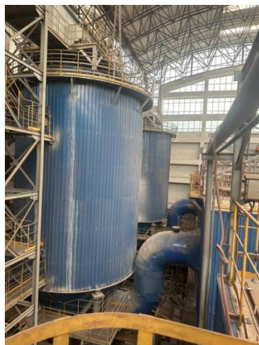
图4.1-2旋转脱酸塔
