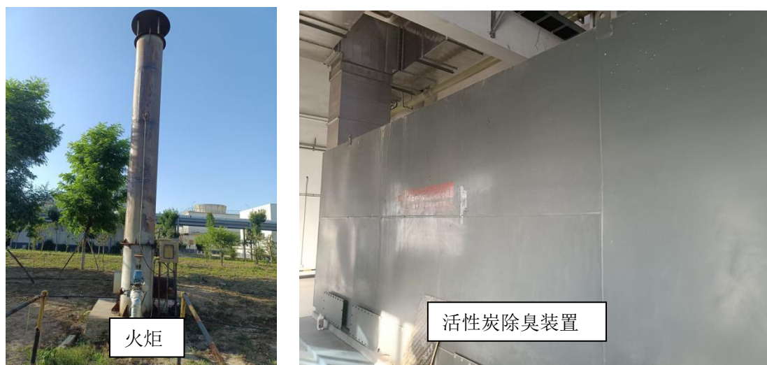
图4.1-9 停炉期间臭气处理系统
