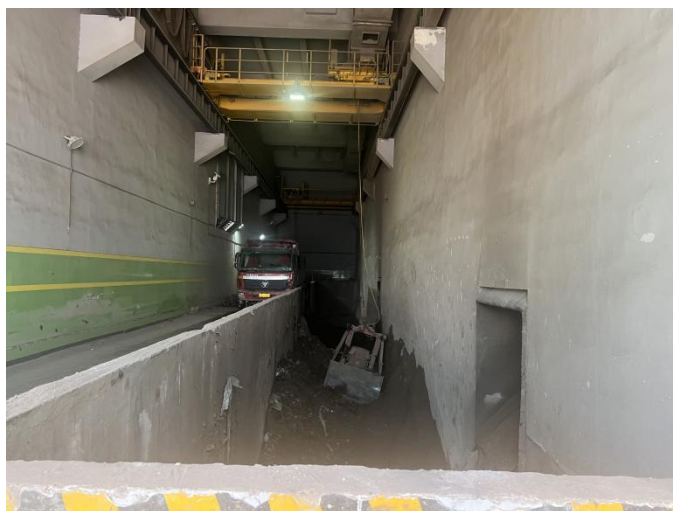
图3.5-8 渣坑现场照片
